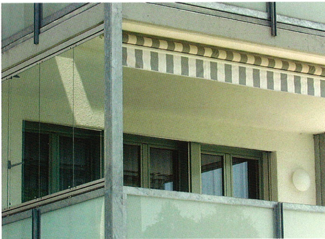
Abb 5: Die Stahlprofile des Geländers sind feuerverzinkt.
