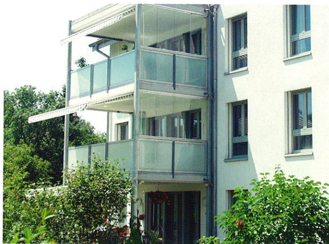
Abb 2: Balkone als eigenständige Elemente vor der Fassade
