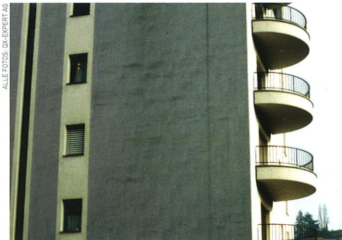
Abb 1: Balkone als Auskragung der Geschossdecke
